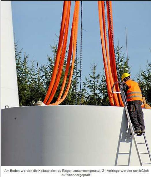
Am Boden werden die Halbschalen zu Ringen zusammengesetzt. 21 Vollringe werden schließlich aufeinandergeprallt.
