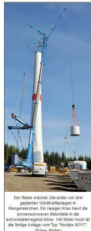
Der Riese wächst: Die erste von drei geplanten Windkraftanlagen in Mengerskirchen. Ein riesiger Kran hievt die tonnenschweren Betonteile in die schwindelerregend Höhe. 140 Meter hoch ist die fertige Anlage vom Typ "Nordex N/117". (Fotos: Röder)
